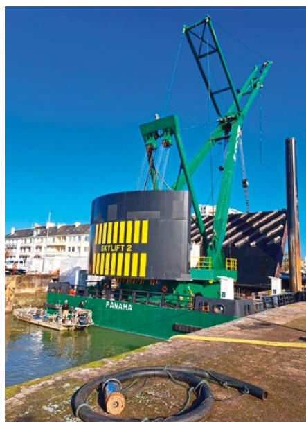
A l'aide de la barge biguée Skylift 2 , la société hollandaise Ravestien a opéré le remplacement des vantaux, dont chacun pèse 160 tonnes.
